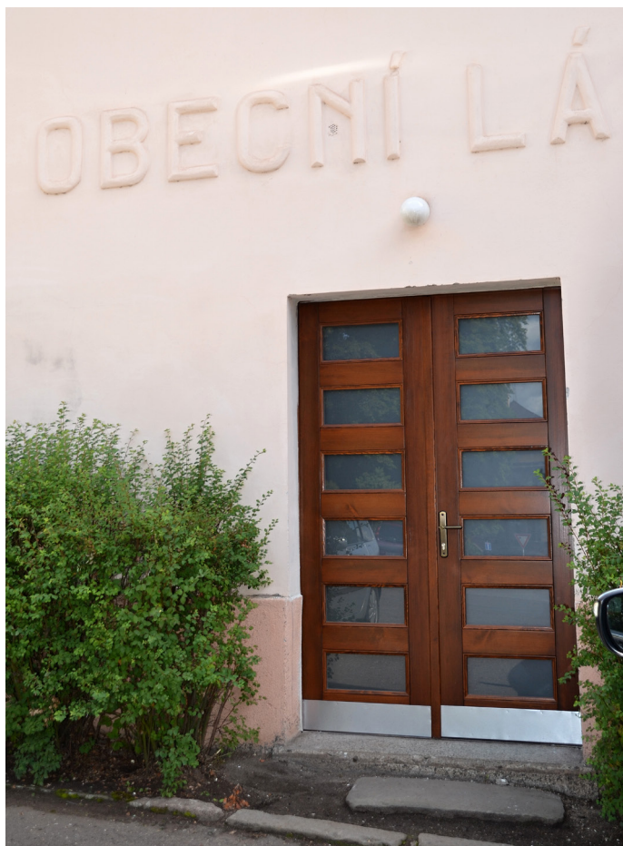
Nové dveře a výměna oken na lázeňském domě
