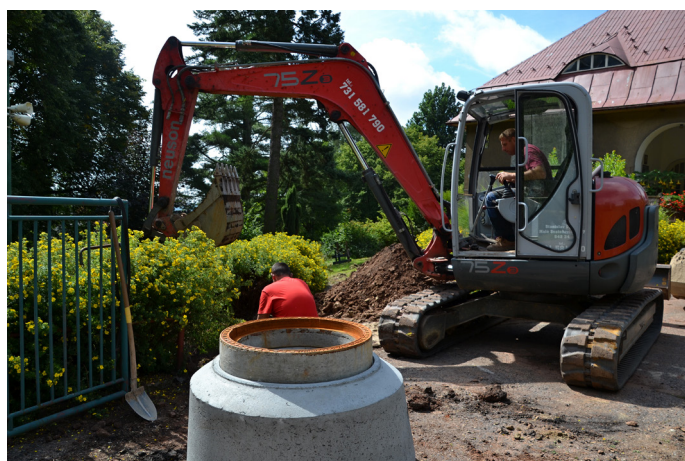
Výstavba kanalizační přípojky u budovy horní školy
