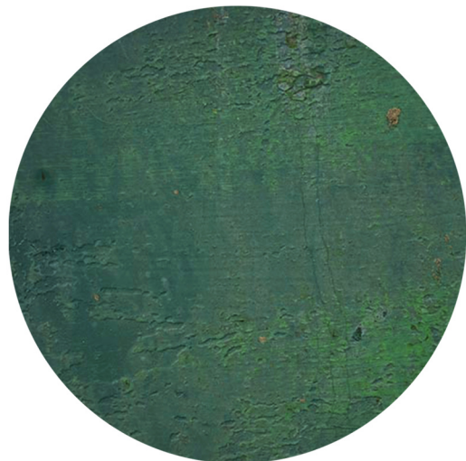
Obnova pôvodnej strešnej krytiny
