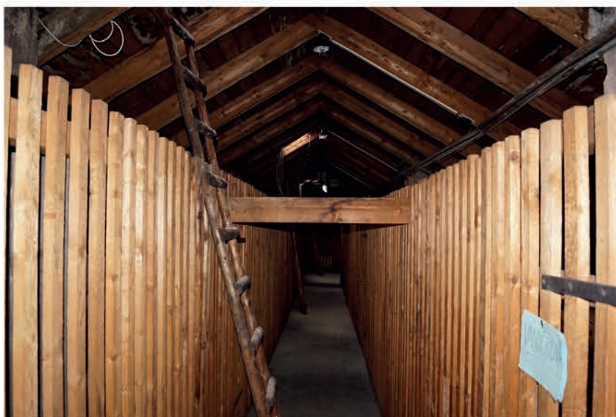
pohled do krovu
