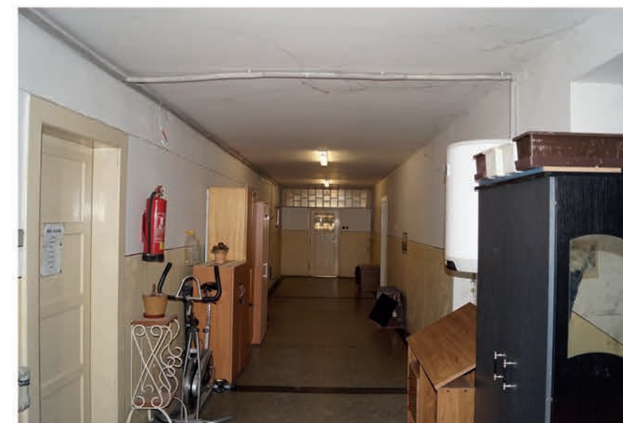
pohled do chodby ve 3NP u městských bytů
