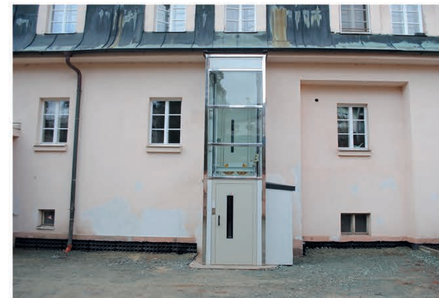
nedávno vybudovaný výtah na východní fasádě
