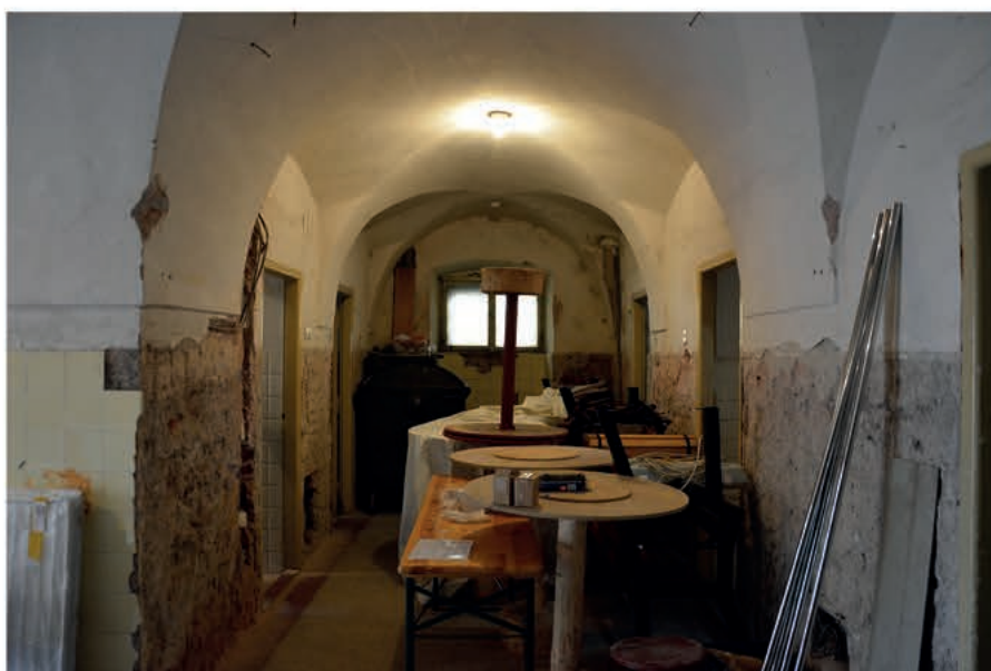
1NP - bývalé lázně, chodba
