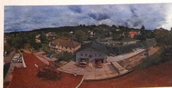
Nově rekonstruovaná hasičárna. září 2021 (panoramatický záběr z dromu)
