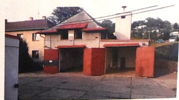
Vystěhovaná hasičárna před zahájením rekonstrukce srpen 2019
