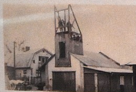
Bourání nepotřebné věže staré hasičárny. Snímek pořízen někdy v 2. polovině 50. let (stejně 1957).
