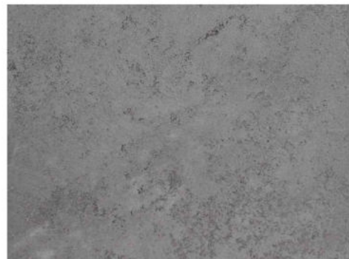
POHLEDOVÝ BETON Lávka v zadní části objektu
