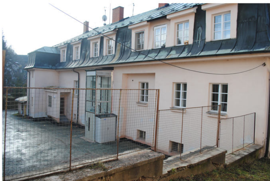
Zadní strana objektu s přístavbami
