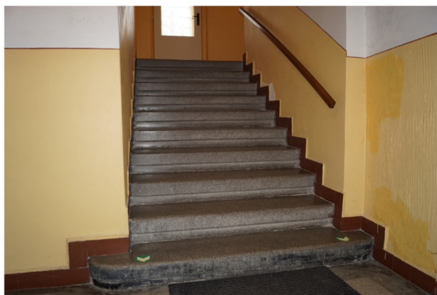
Schodiště v levém křídle budovy
