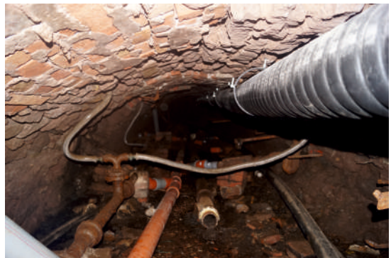
PRAMEN POD OBJEKTEM, ZASTARALÉ POTRUBÍ
