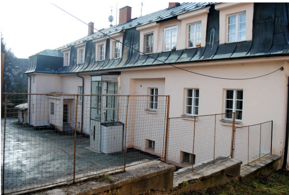
NEVHODNÉ PŘÍSTAVBY, NOVÉ OKNO NARUŠUJÍCÍ PŮVODNÍ RYTMUS OKENNÍCH OS
