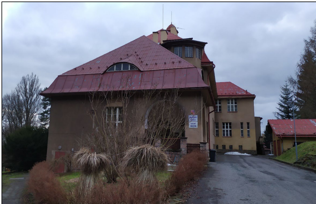
Obrázek 27: Budova ve Schejbalově ulici č. p. 131 – budova 1. stupně ZŠ – stav k únoru 2023
