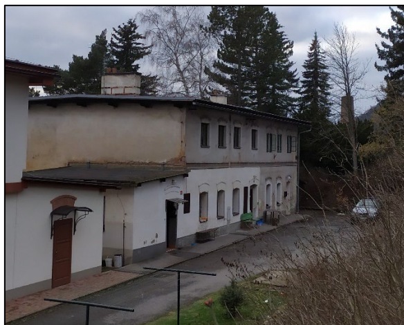
Obrázek 31: Objekt k bydlení s č. p. 76 – stav k únoru 2023
