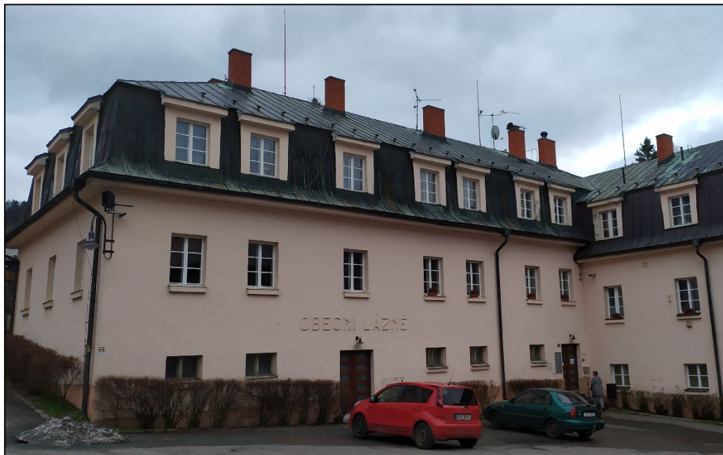
Obrázek 24: Budova bývalých obecních lázní – stav k únoru 2023
