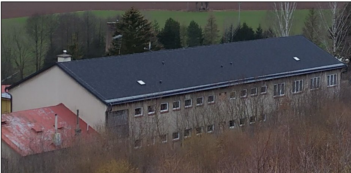
Obrázek 33: Budova s č. p. 188 – stav k únoru 2023
