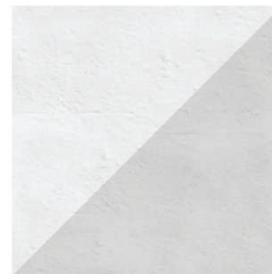
povrchová úprava fasád a plastické nápisy na fasáde - vápenná omietka, lomená biela a sivá
