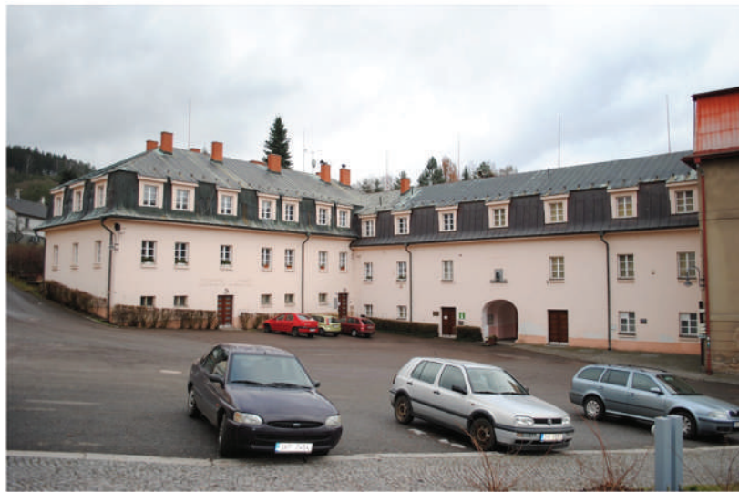
pohľad na objekt z námestia
