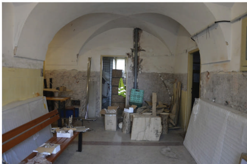
vstupný priestor bývalých kúpeľov
