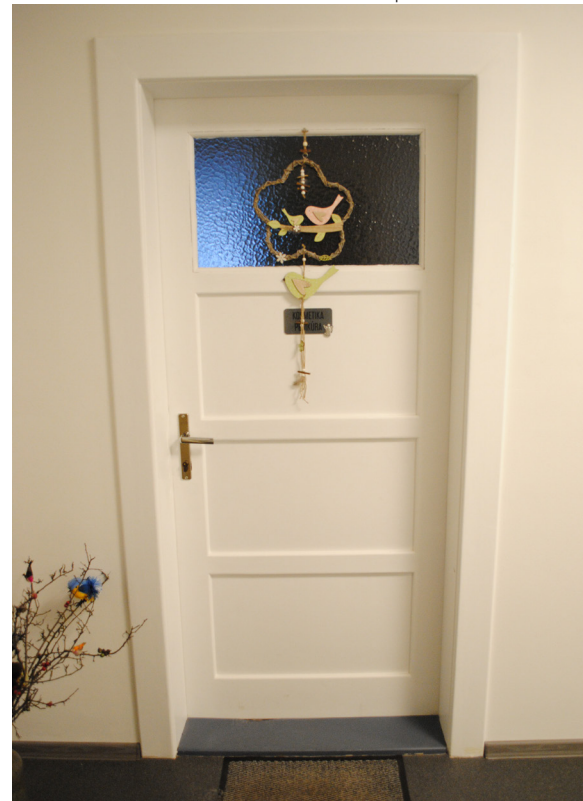
Vnitřní dřevěné rámové dveře s prosklením
