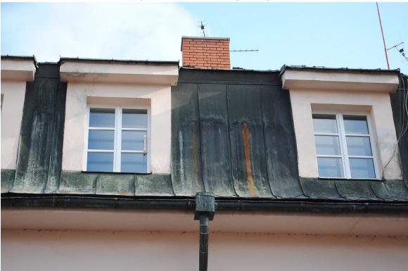
Nevhodné prostupy kanalizace ve zdivu
