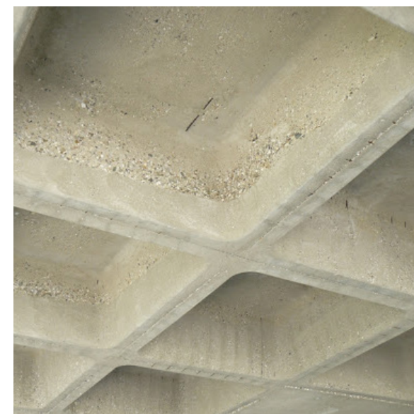
Pohledový monolitický železobeton
