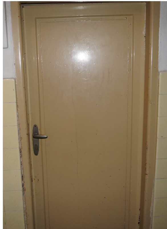
Vnitřní ocelové dveře s ocelovou zárubní
