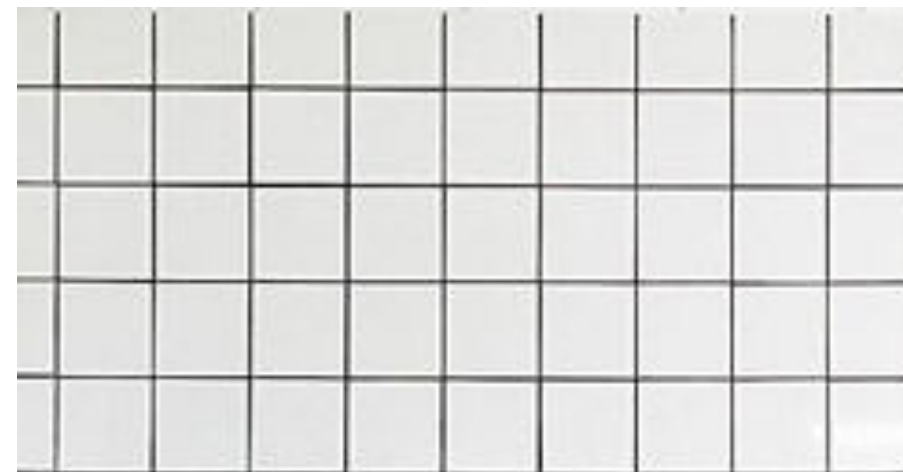
bílé kachličky obklad WC, šatny
