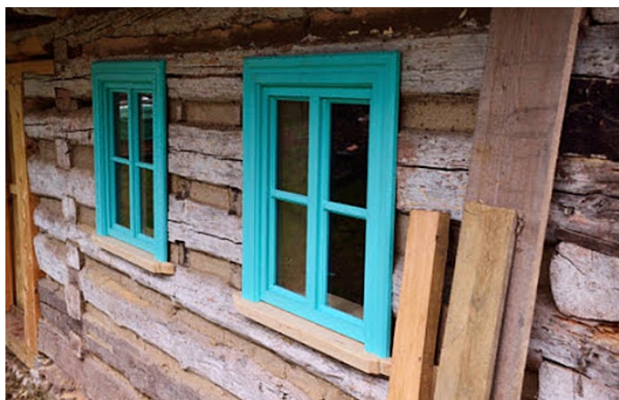
Nová okna na kostelnickém domku
