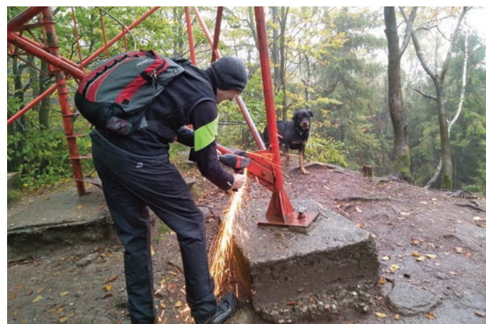
Pomyslné zahájení demolice původní rozhledny
