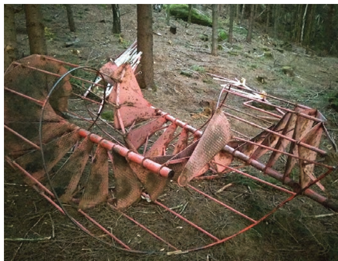
Demontované části rozhledny
