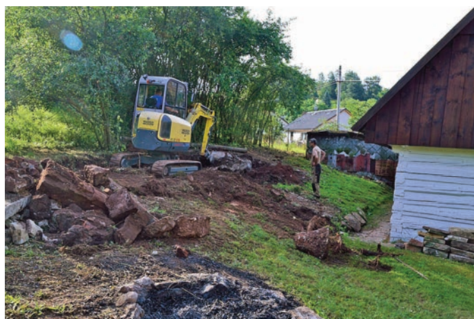
Terénní úpravy kolem kostelnického domku
