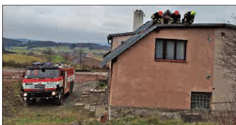
Výjezd č. 39 - uvolněná střecha
