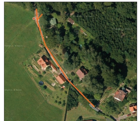
Opravovaný úsek v ulici Schejbalova
