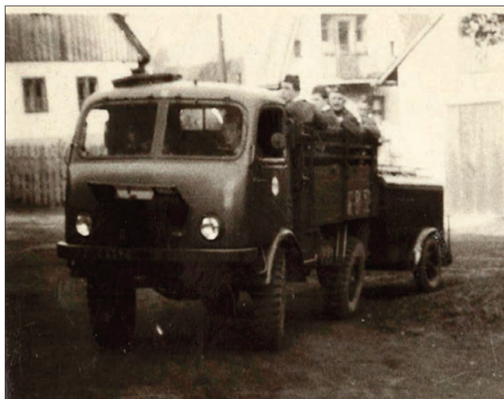
Dopravní automobil DA-8 Tatra 805 v soupravě se stříkačkou PPS-8. Snímek pořízen zřejmě někdy na přelomu 50. a 60. let 20. století
